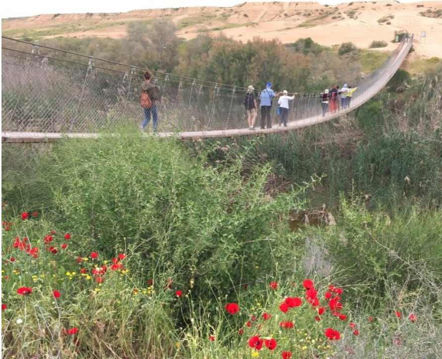
Bildet over: Hengebroa over Besor-bekken. Bildet til høyre: Inngangen til broa fra vest.
