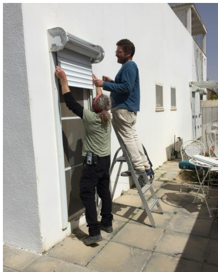
Elektrikeren sjekket alle elektriske ytterdører, her sammen med naboen vår, Gilad, som hjelper.
