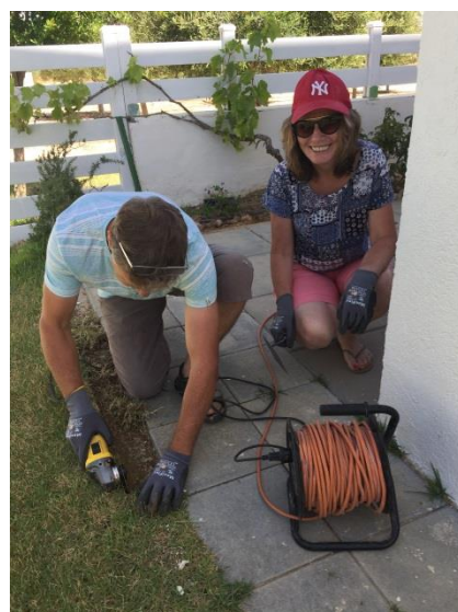
Et tysk ektepar, Viktor og Klara, var i huset i fire dager og jobbet med renovering og forsterkning på tak og ellers rundt mange steder.
