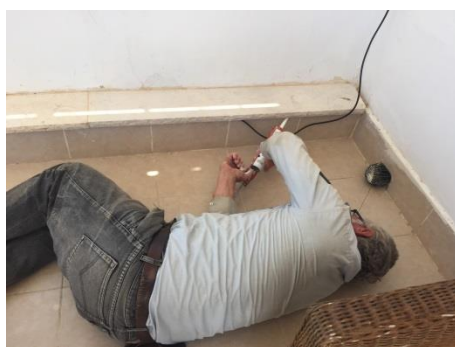
Arthur fester vannledningen til urnene på taket. Der har vi en liten vanncomputer som sørger for mengde av vann til urnene og når tid det skal vannes.
